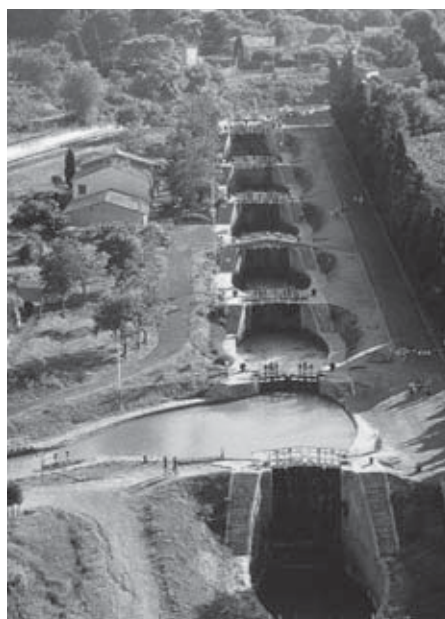
Rys. 4. Słynny zespół 8 kaskadowych śluz w miejscowości Fonserrannes o charakterystycznym jajowatym kształcie pozwala na pokonywanie różnicy poziomów 21,5 m.
