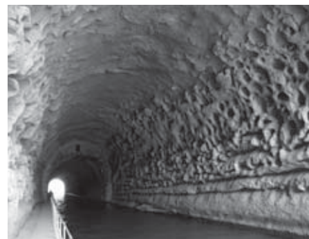
Rys. 5. Tunel kanałowy Malpas.
